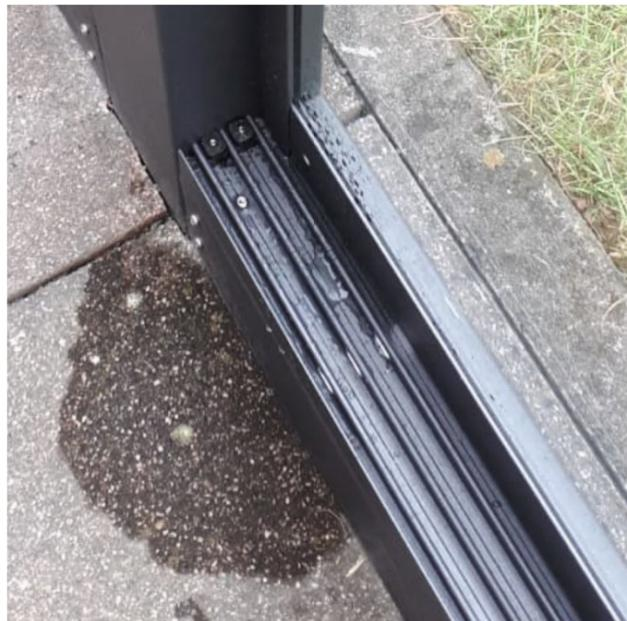
Jegliche Ausbauelemente sind nicht wind- & schlagregendicht konstruiert. Bei stärkeren Niederschlägen und Winddruck kann Wasser eintreten.
