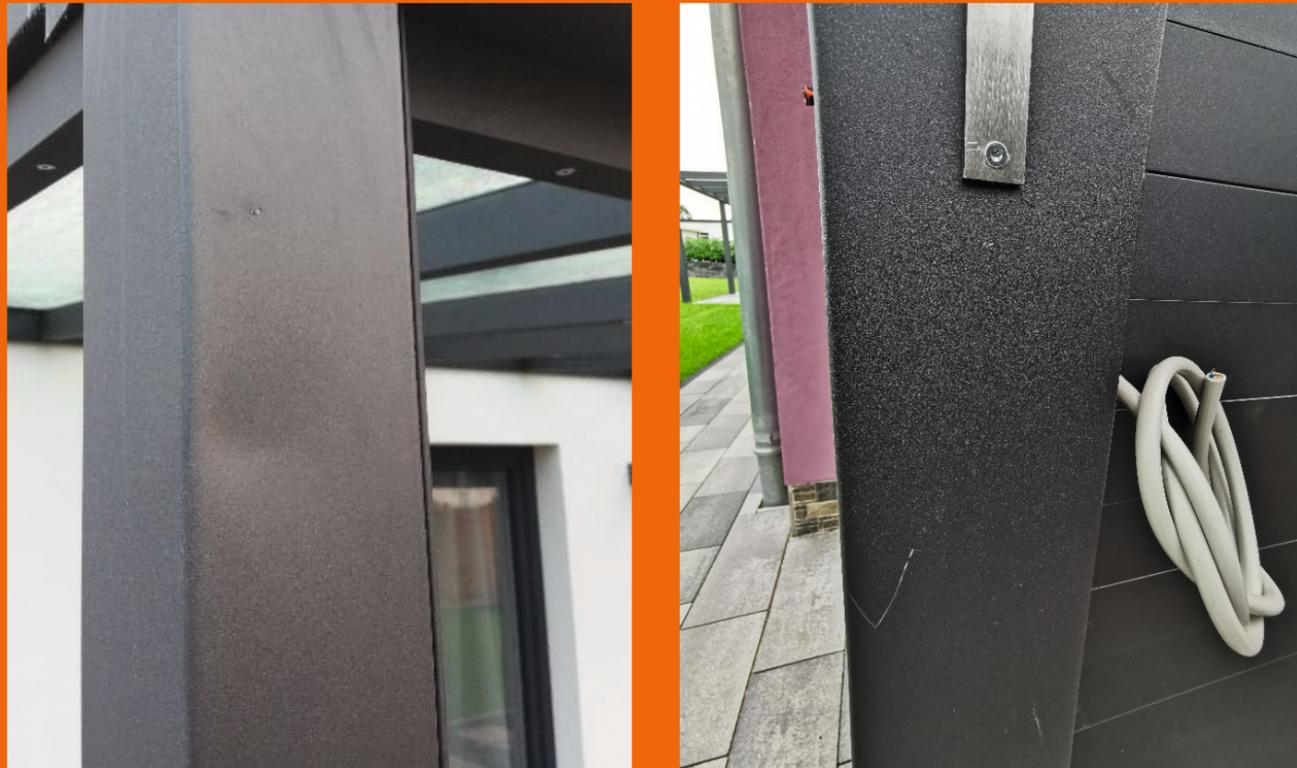
Bei kleinen Schleifspuren wird eine Ausbesserung mit einem Lackstift vorgenommen. Falls dennoch der Austausch des Bauteils gewünscht wird, so muss dieser in Höhe der Hersteller- und Lohnkosten berechnet werden.
